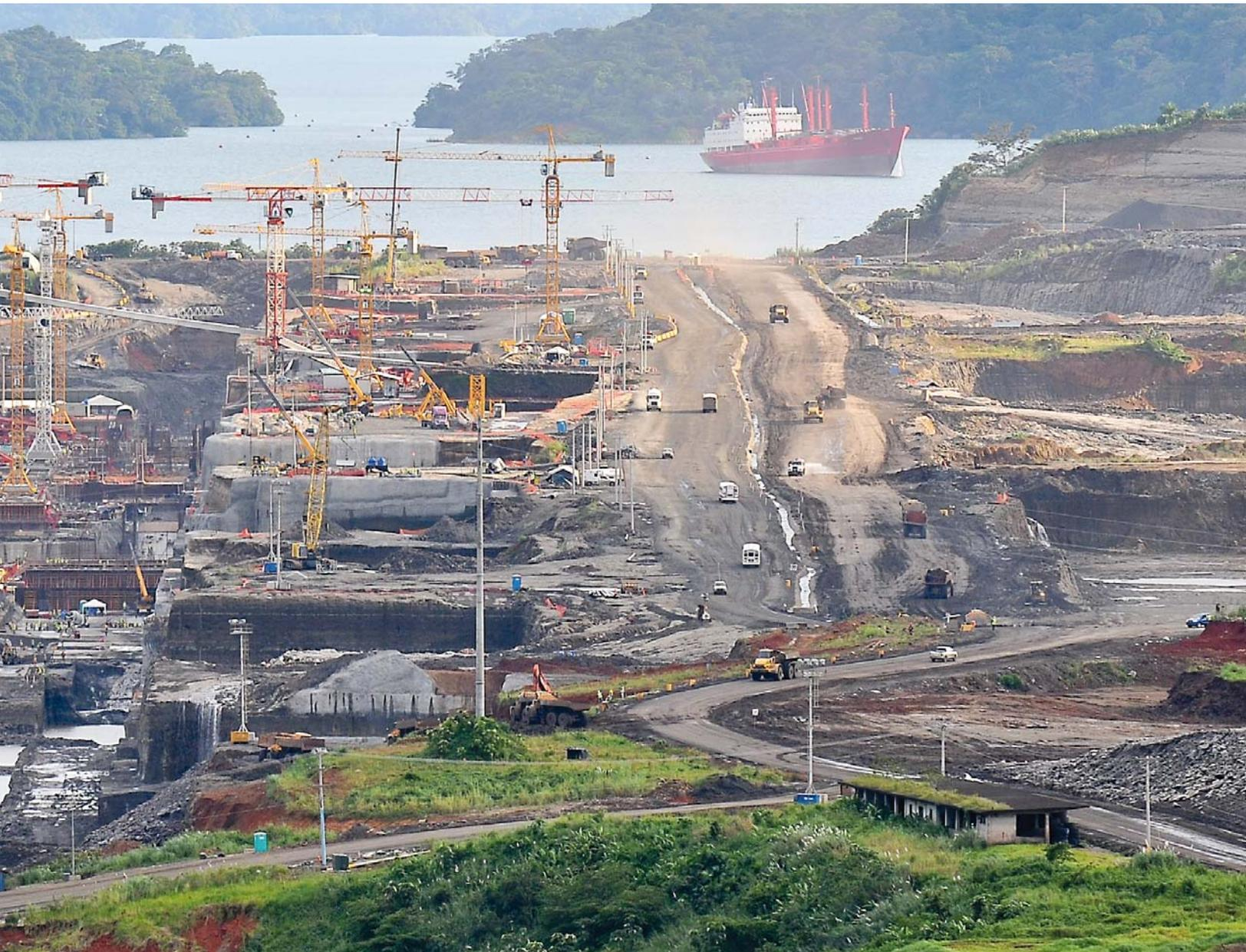
*En el Atlántico, la construcción del Tercer Juego de Esclusas se desarrolla en lo que antes fue la excavación realizada por los estadounidenses en 1939. Los adelantos de la excavación dieron paso a los trabajos civiles en julio de 2011 con la colocación del primer concreto estructural en el piso de la cámara superior.*
