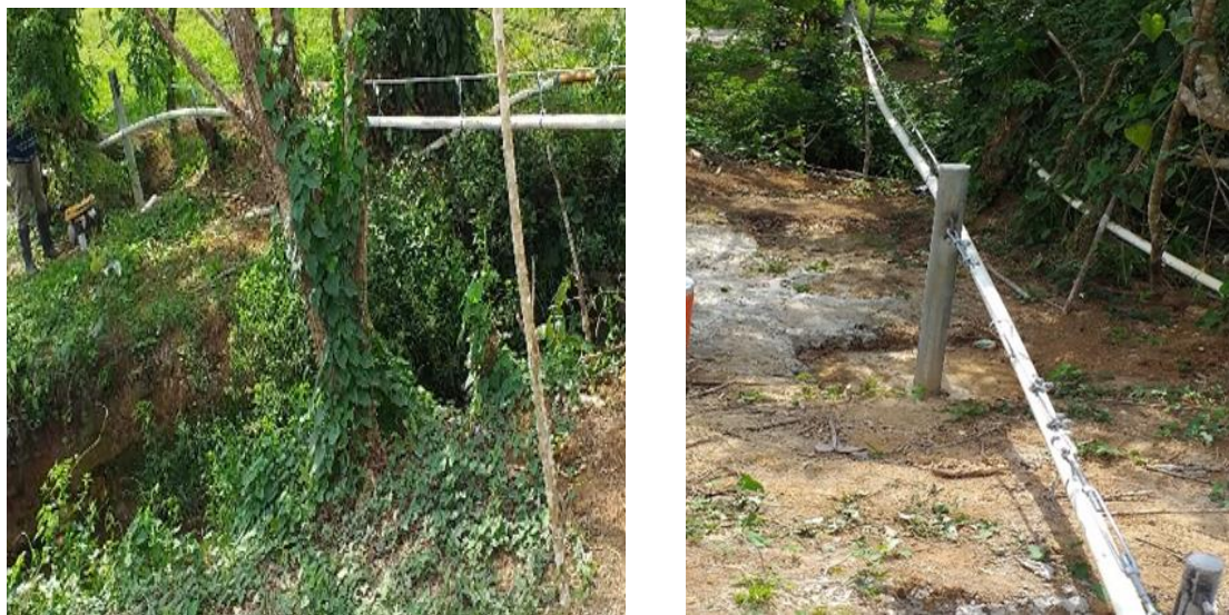
Figura 38- Vista de tercer cruce aéreo - El Limón
