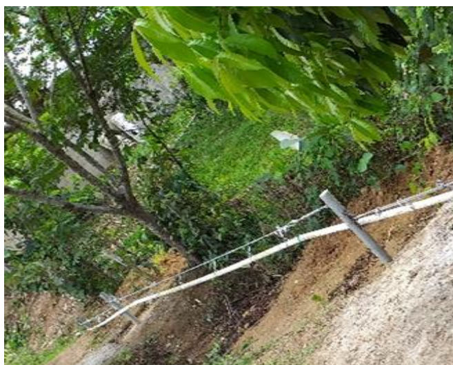
Figura 39- Vista de cuarto cruce aéreo - El Limón
