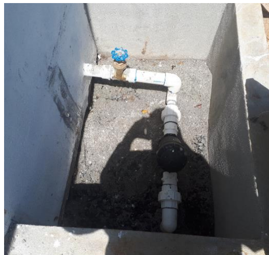
Figura 21- Cajas de válvulas con su tapa, válvulas y filtro - Barriada San Antonio
