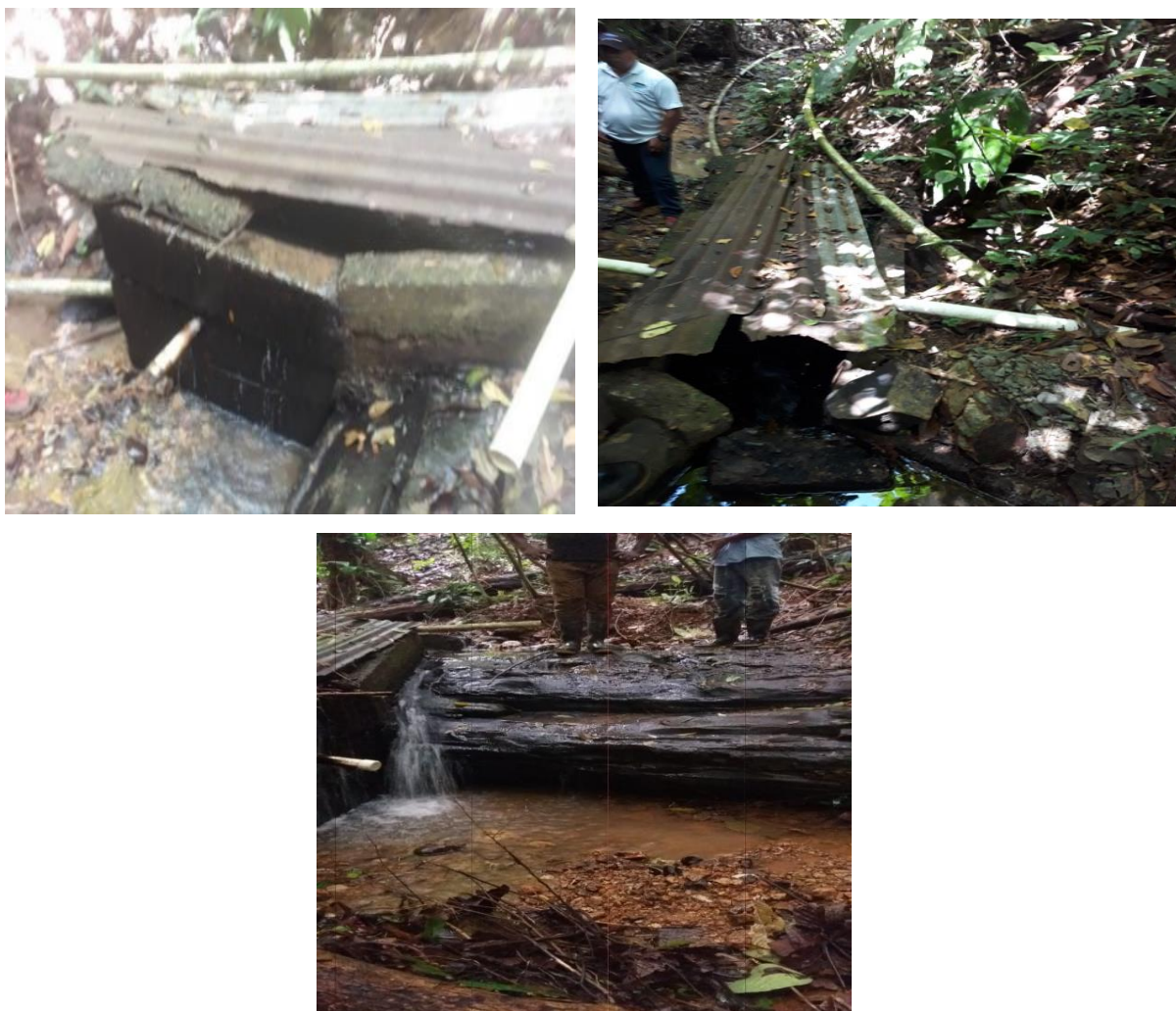
Figura 10- Vistas de condiciones iniciales de captación superficial en la quebrada El Tornito - El Limón
