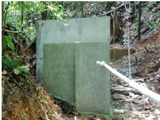
Figura 28- Nueva captación superficial - El Limón
