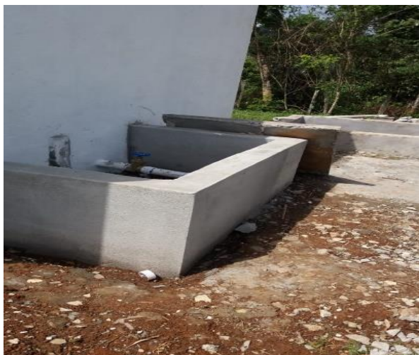
Figura 21- Cajas de válvulas con su tapa, válvulas y filtro - Barriada San Antonio
