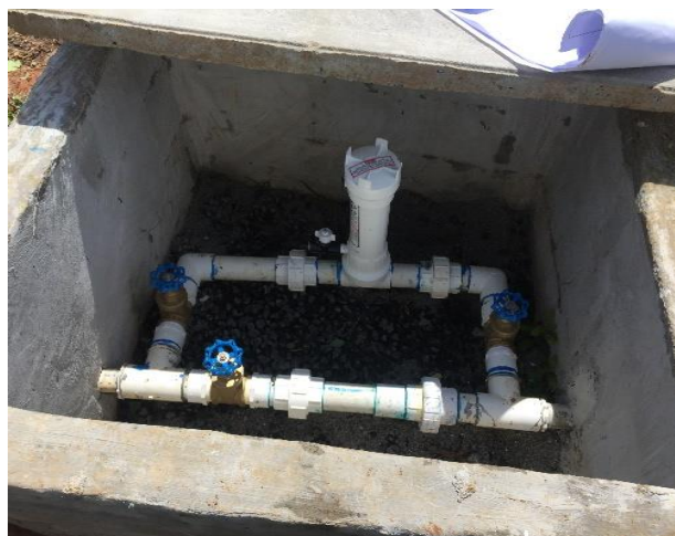
Figura 17- Caja y clorinador nuevo - La Conga Abajo y Tres Hermanas Centro
