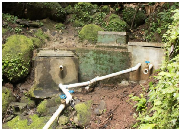
Figura 19- Cajas de captación mejoradas - La Barriada San Antonio
