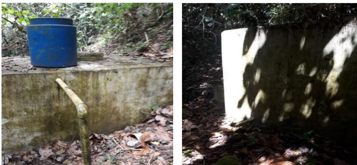
Figura 11- Vistas de condición inicial de tanque de almacenamiento - El Limón
