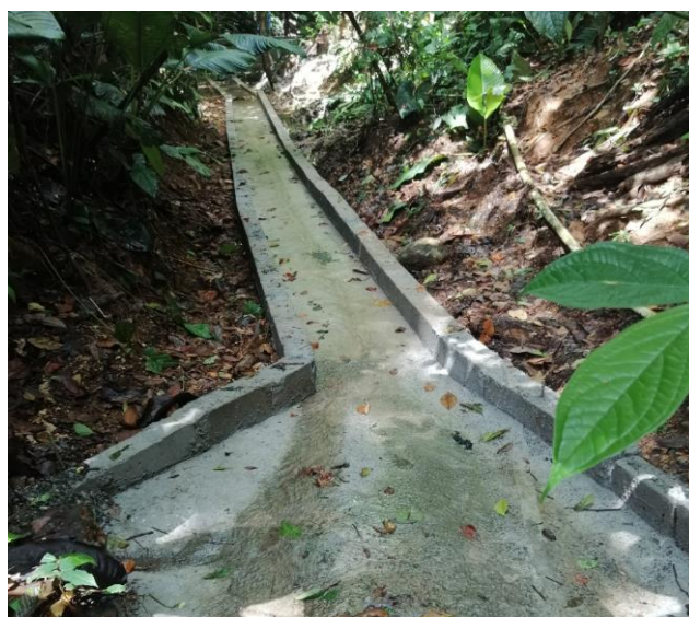
Figura 31- Canal de captación superficial - El Limón
