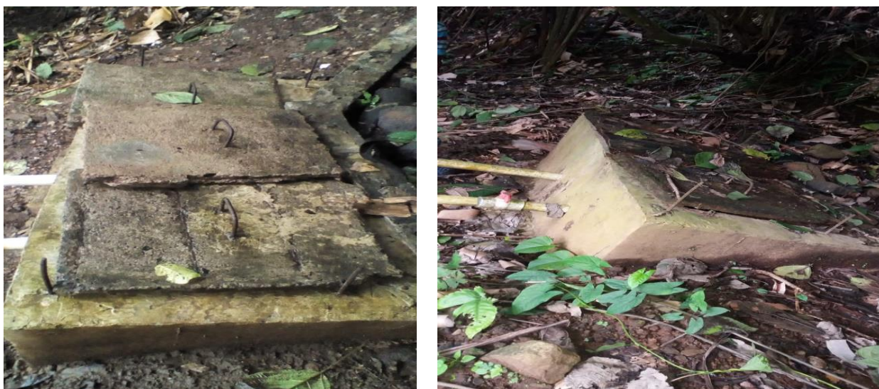
Figura 2- Vistas de condiciones iniciales de captación 2- Sector Tres Hermanas Centro y La Conga Abajo
