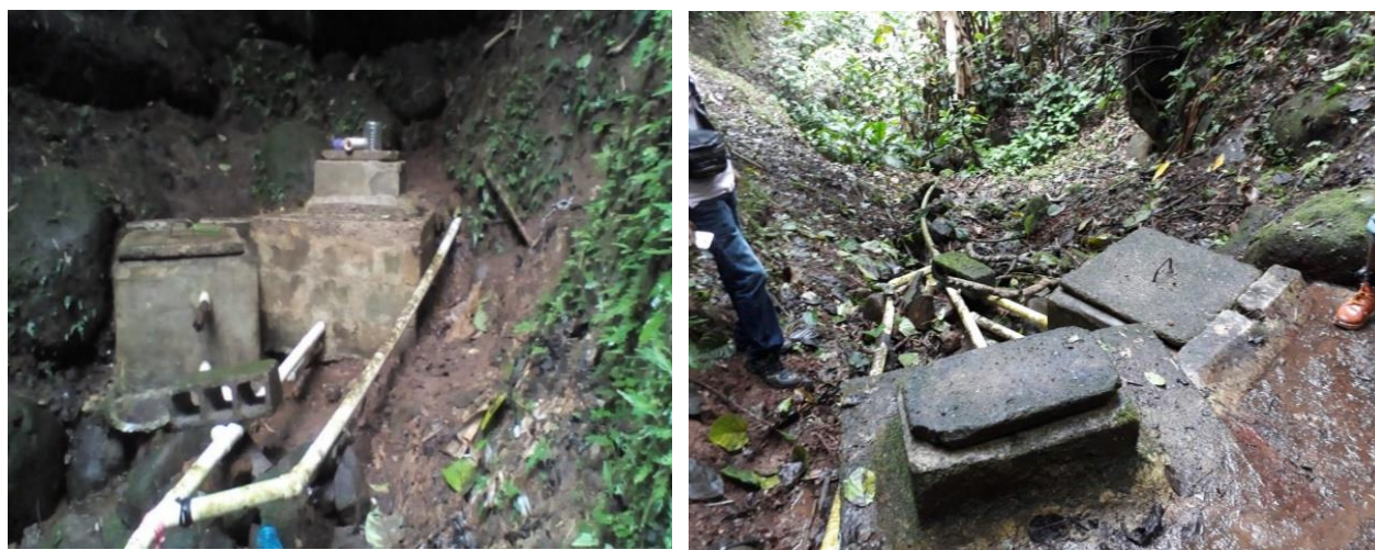
Figura 6- Vistas de condiciones iniciales de captación - Barriada San Antonio
