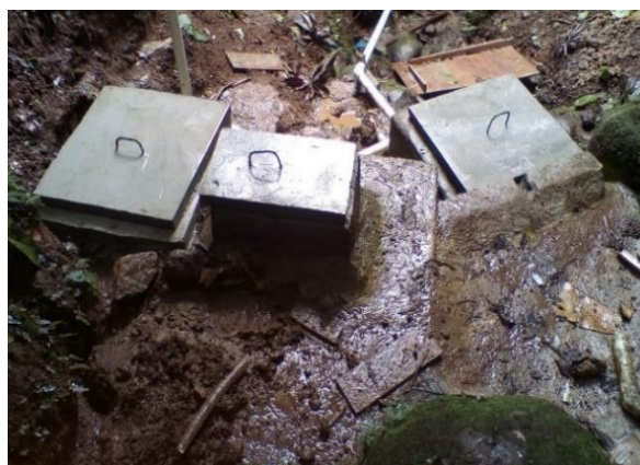
Figura 19- Cajas de captación mejoradas - La Barriada San Antonio
