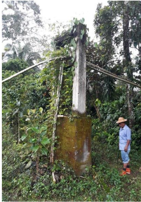
Figura 8- Vistas condiciones iniciales cruce aéreo río Teriá
