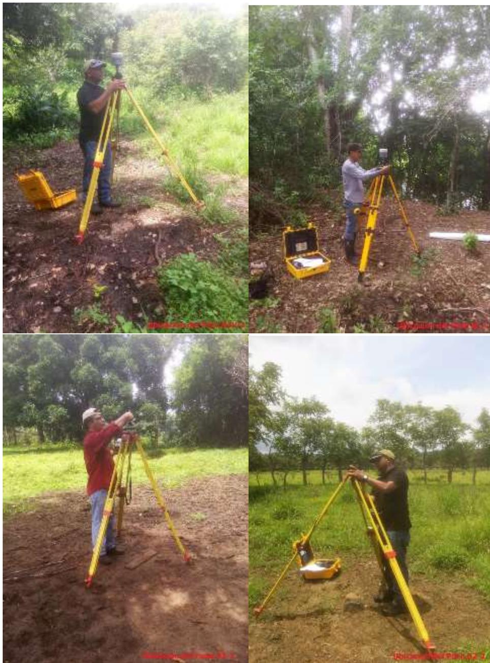
Figura 7. Levantamiento en XYZ en los puntos de perforación y calicatas para darle valores reales. Fuente: ACP
