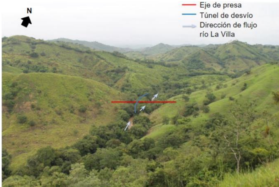
Fotografía 1. Localización de las obras relacionadas al sitio de presa (El Gato).
