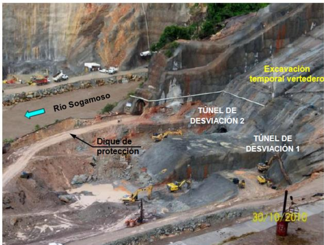
Fotografía 4. Vista general de portales de salida de túneles de desvío y diques naturales de protección (Proyecto Sogamoso, INGETEC 2010).
