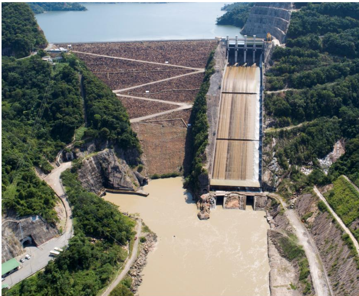
Fotografía 5. Vista general de aguas abajo de la presa y vertedero de la C.H. Sogamoso con los portales de salida de los túneles de desvío integrados al cuenco de amortiguación e inundación del mismo por las descargas de la casa de máquinas y filtraciones de pie de presa (Central Sogamoso, INGETEC 2018)
