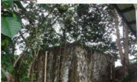
TANQUE DE AGUA
