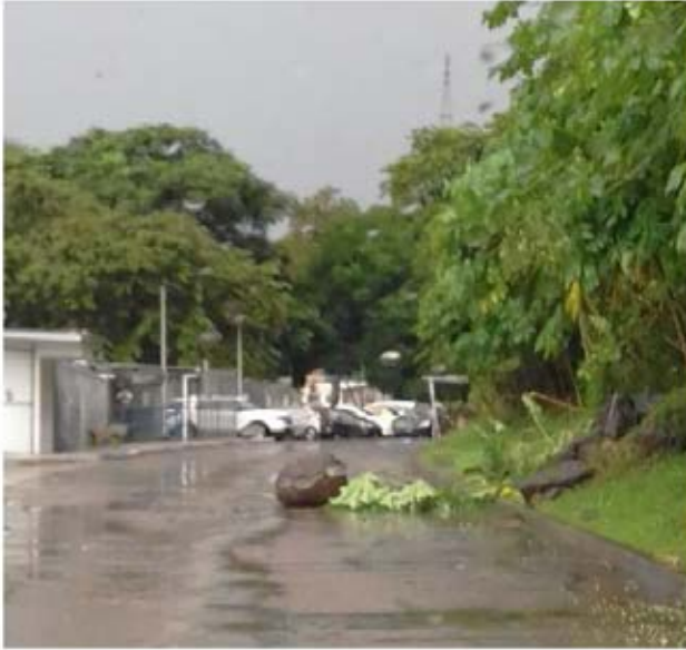
Figura No. 22. Desprendimiento de roca, 2017
