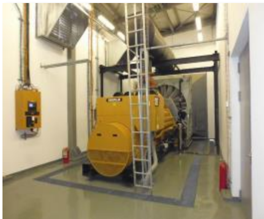
Figura 3-3. Generador de respaldo
