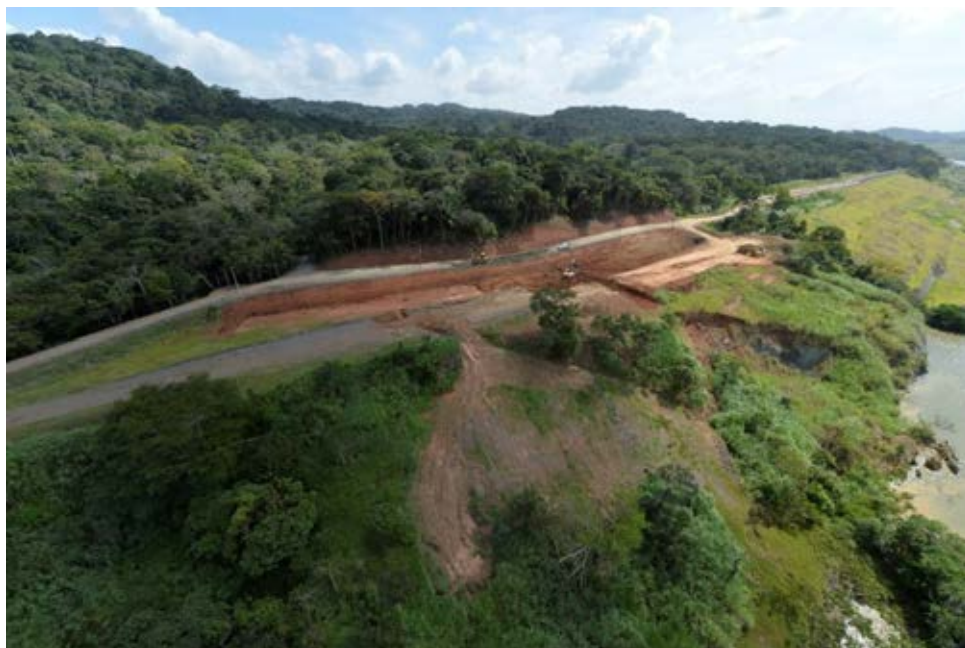
Figura No. 6. Vista aérea de los trabajos de excavación del deslizamiento de East Whitehouse, 20 de diciembre 2017
