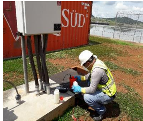
Foto 4: Monitoreo de Separador de Agua y Aceite en Cocolí
