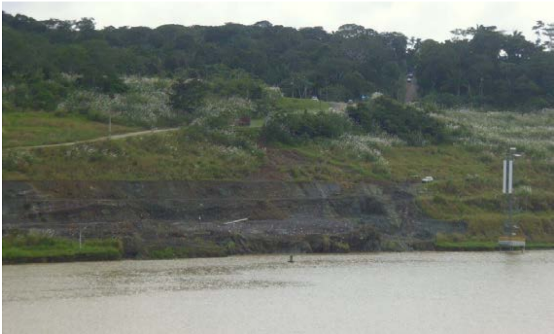
Figura No. 14. Excavación en el área de Cascadas 1
