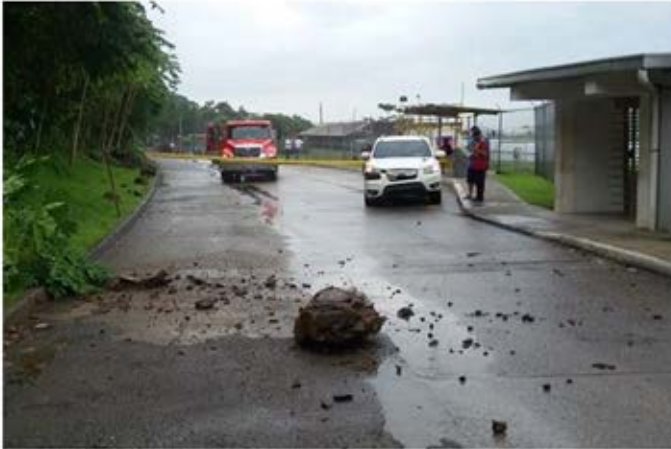
Figura No. 26. Desprendimiento de roca Cerro Paraíso, agosto 2018
