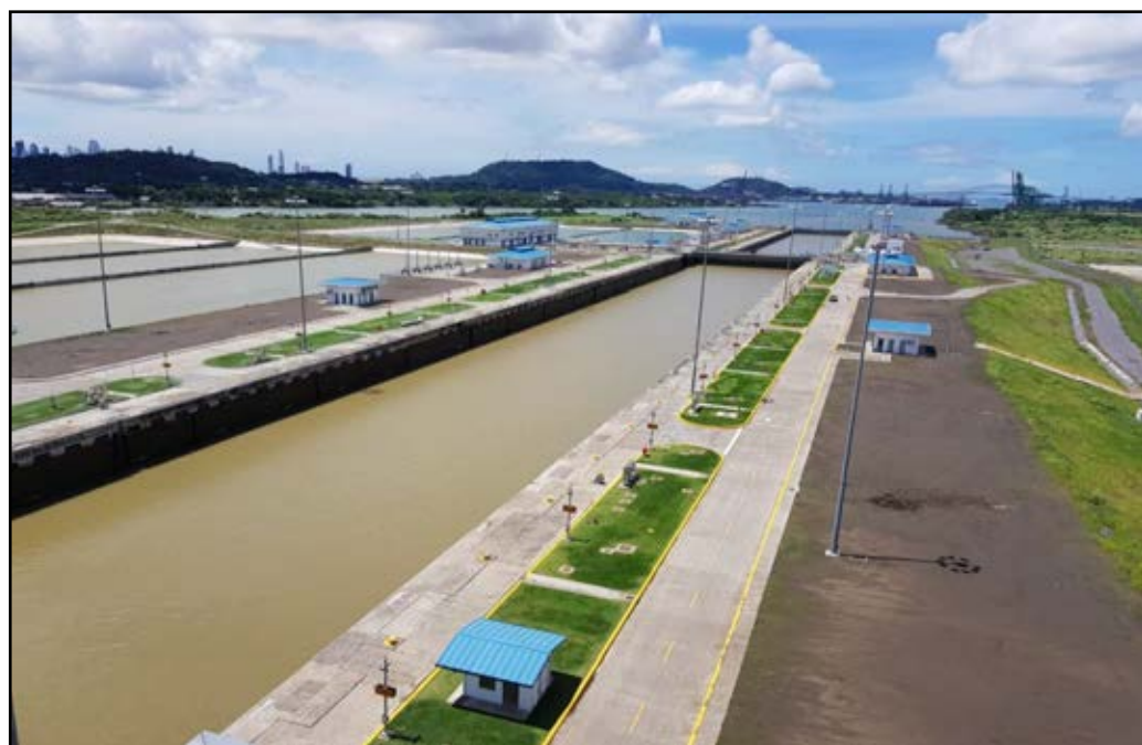
Foto 4. Áreas verdes de las cámaras media lado isla y continente posterior a la siembra de grama en isletas y relleno con material de dragado.
