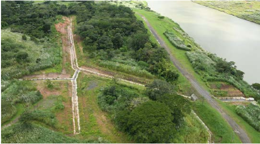
Figura No. 9. Vista aérea de los trabajos finalizados, septiembre de 2018
