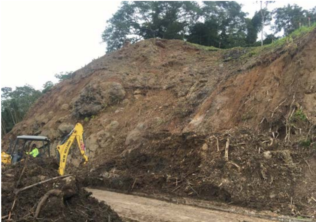
Figura No. 28. Ejecución de trabajos, octubre 2018
