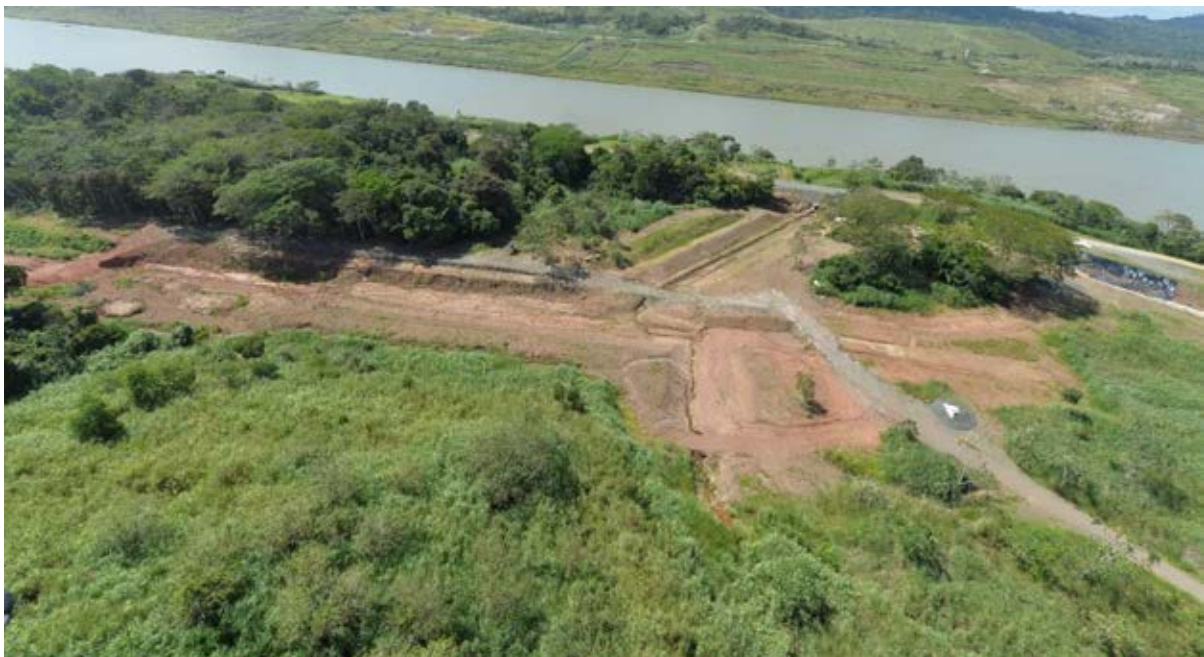
Figura No. 8. Vista aérea de los trabajos de excavación de Summit, 20 de diciembre de 2017
