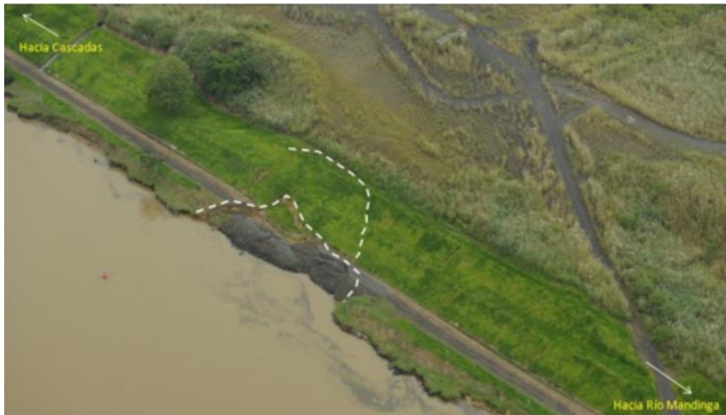
Figura No. 10. Vista aérea del deslizamiento en Obispo
