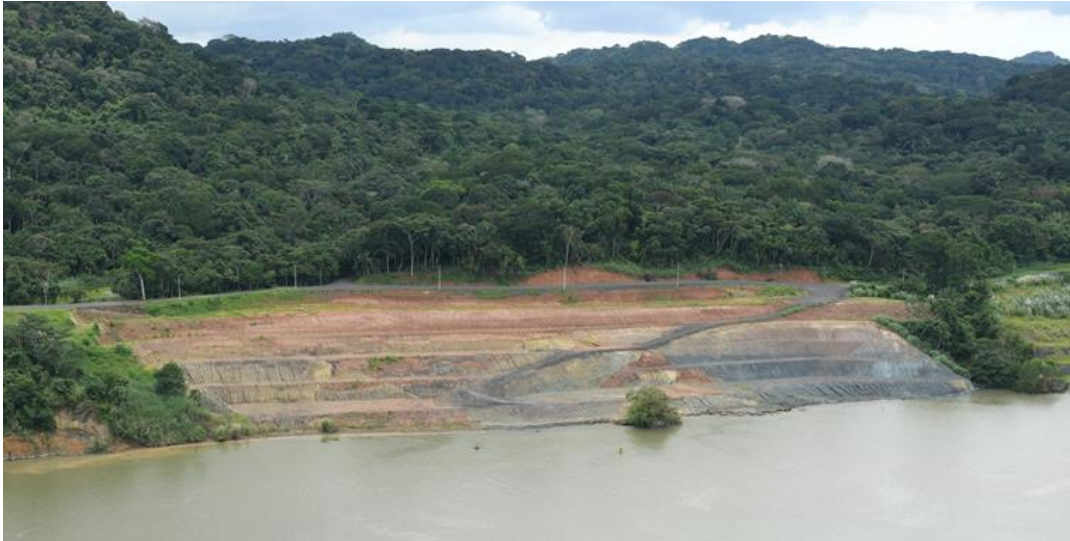
Figura No. 7. Vista aérea de excavación finalizada, septiembre 2018
