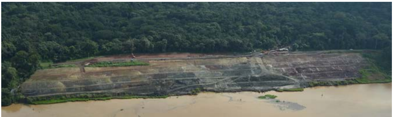
Figura No. 13. Excavación finalizada, Bordada Cascadas
