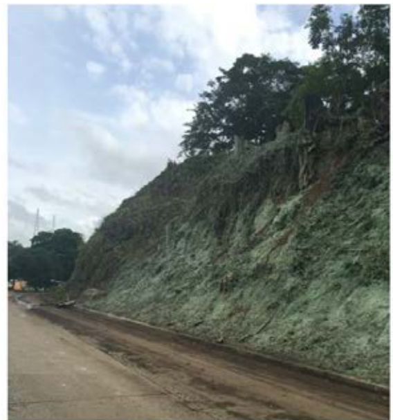
Figura No. 21. Colocación de hidrosiembra, julio 2016
