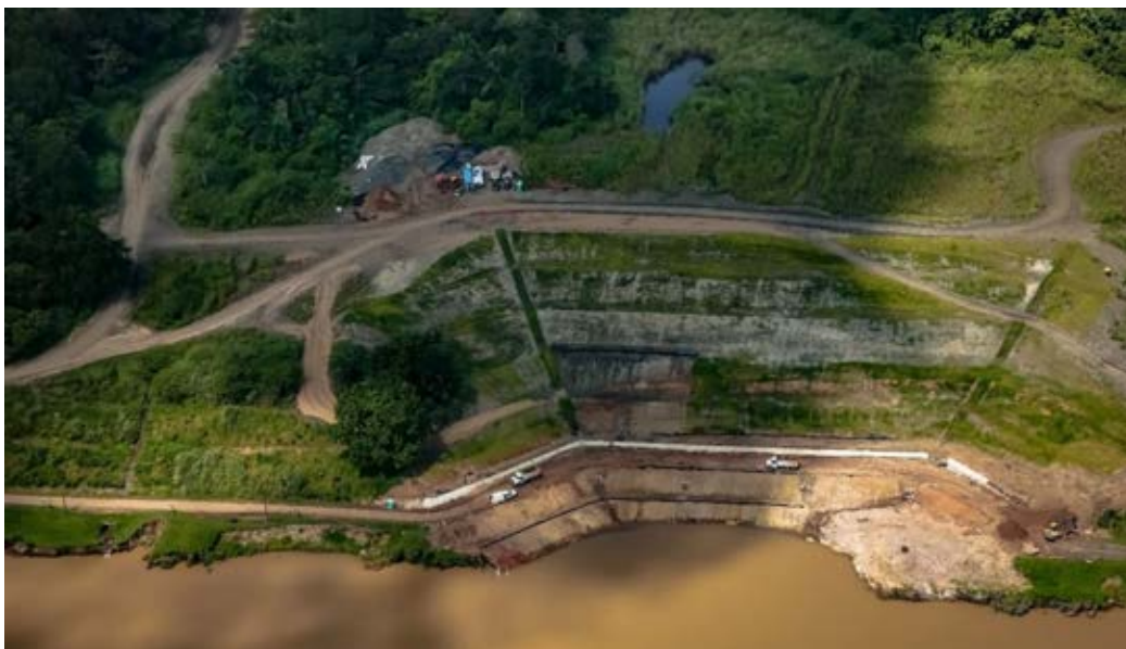
Figura No. 11. Vista aérea de los trabajos de excavación de Obispo finalizados
