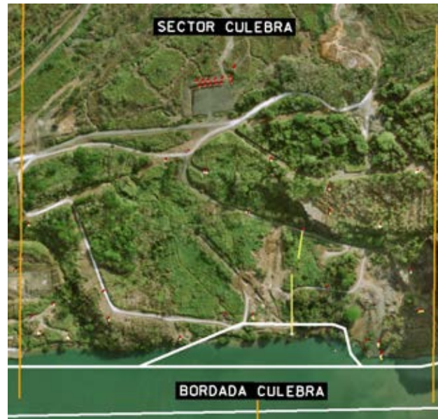
Figura No. 61. Planta de los vectores de desplazamiento del Sector Culebra, año 2018
