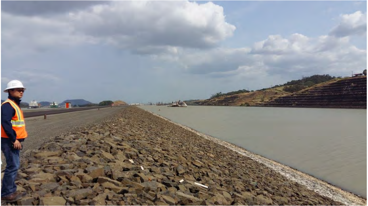
Figura No. 9. Vista sureste, estación aproximada 1+100 (talud interior)
