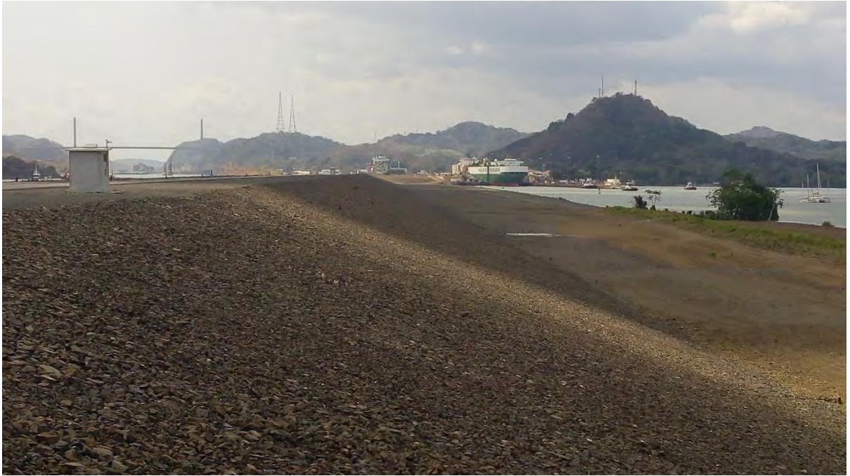
Figura No. 5. Vista noroeste, estación aproximada 2+700 (talud exterior)
