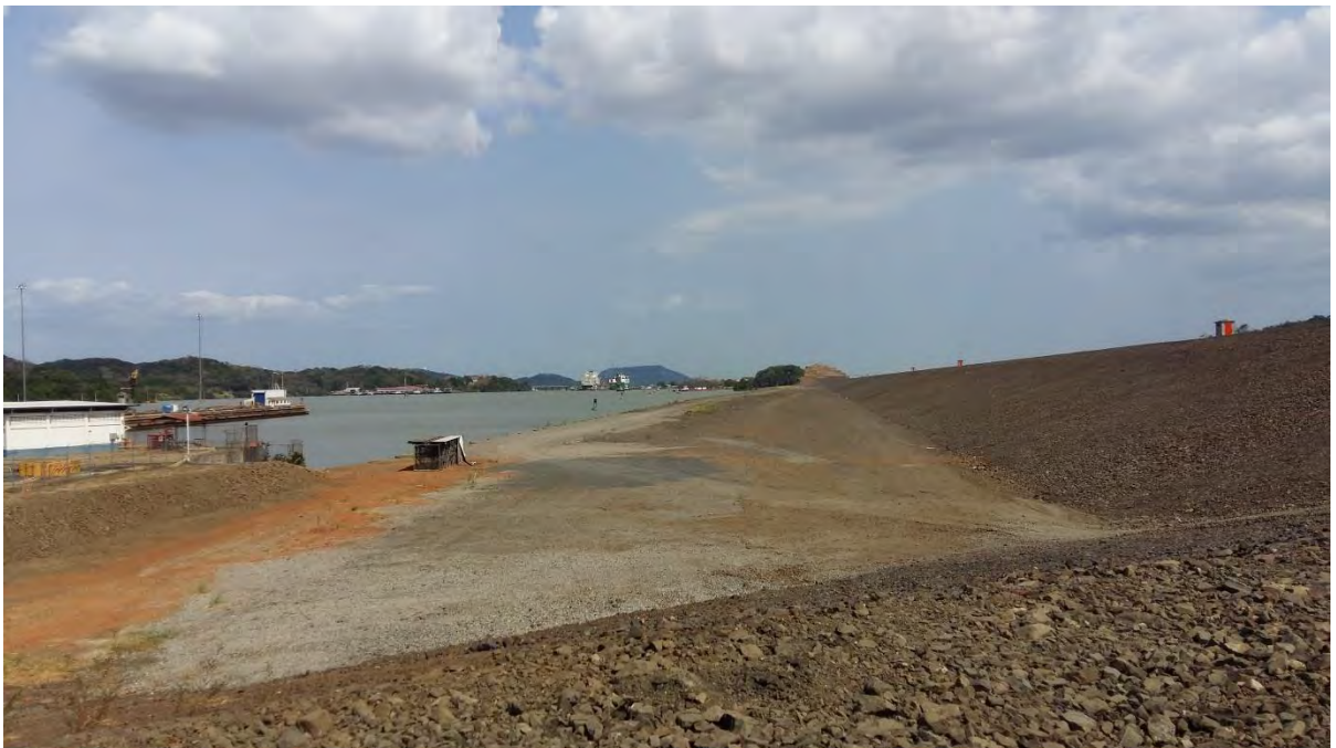
Figura No. 6. Vista suroeste, estación aproximada 0+100, (talud exterior)
