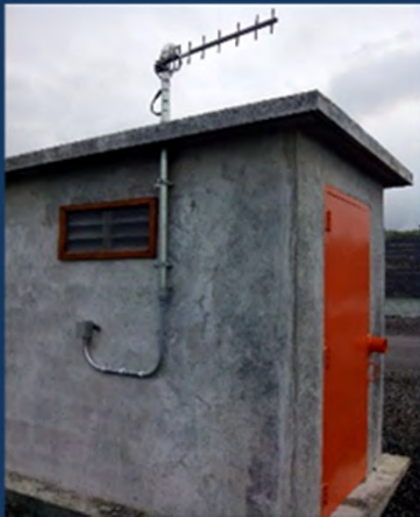
Casetas de instrumentos en represa 1E
