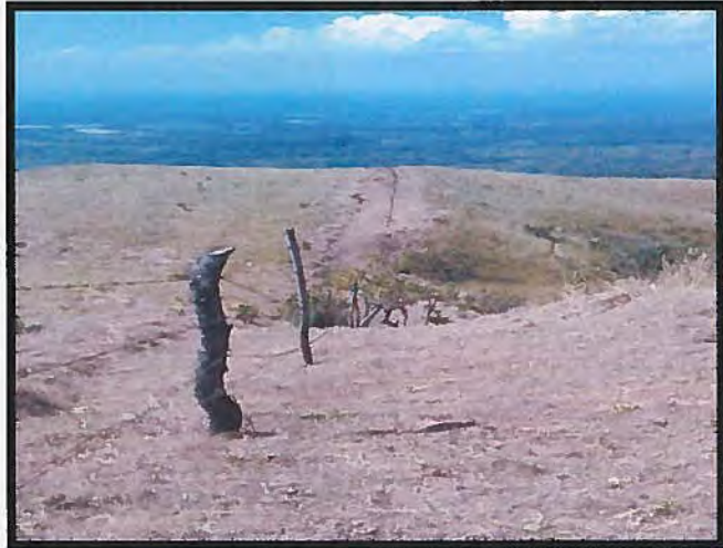
Evidencia enviada por el contratista Tramo de ronda corta fuego realizado.
