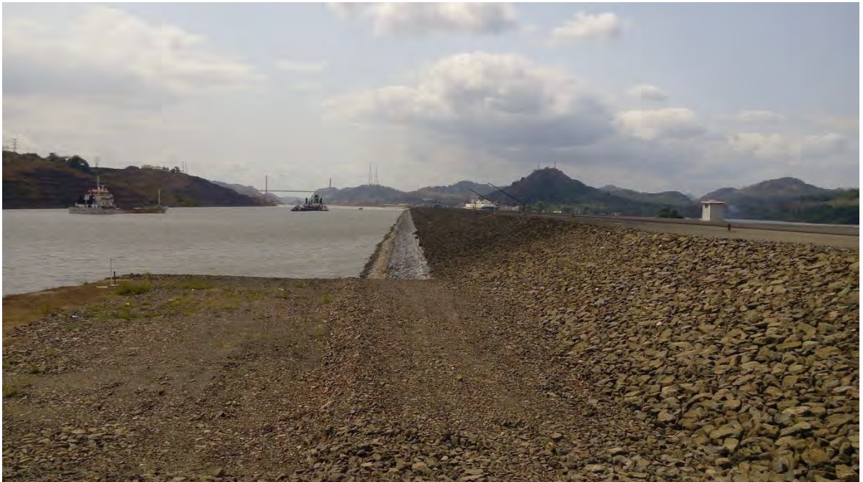
Figura No. 4. Vista noreste, estación aproximada 2+700, (talud interno)
