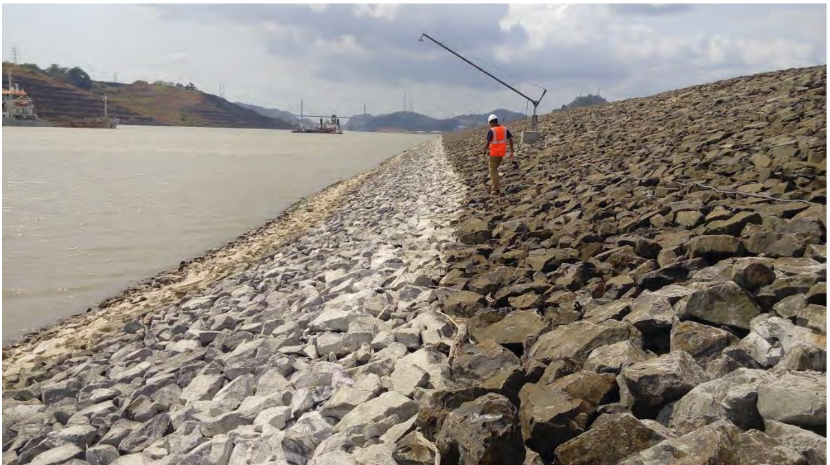
Figura No. 8. Vista noreste, estación aproximada 2+600, (talud interior)
