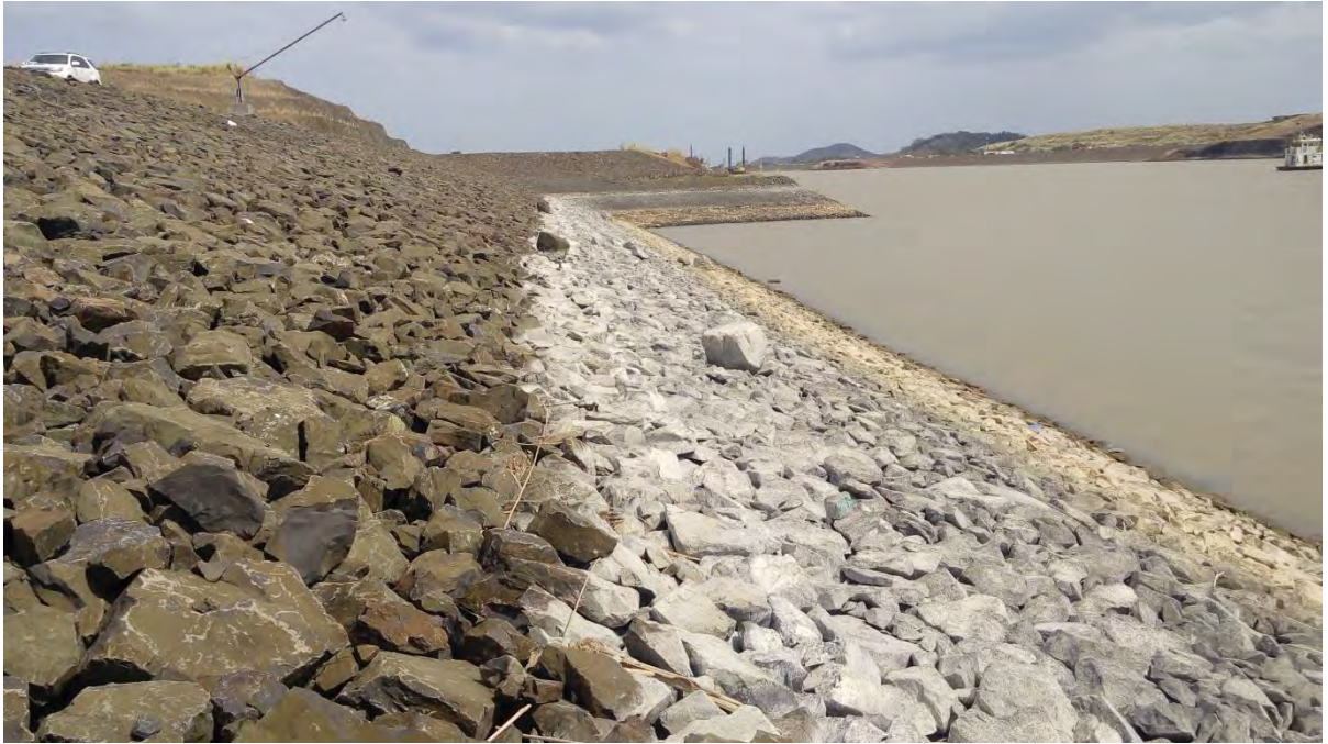
Figura No. 7. Vista sureste, estación aproximada 2+600, (talud interior)
