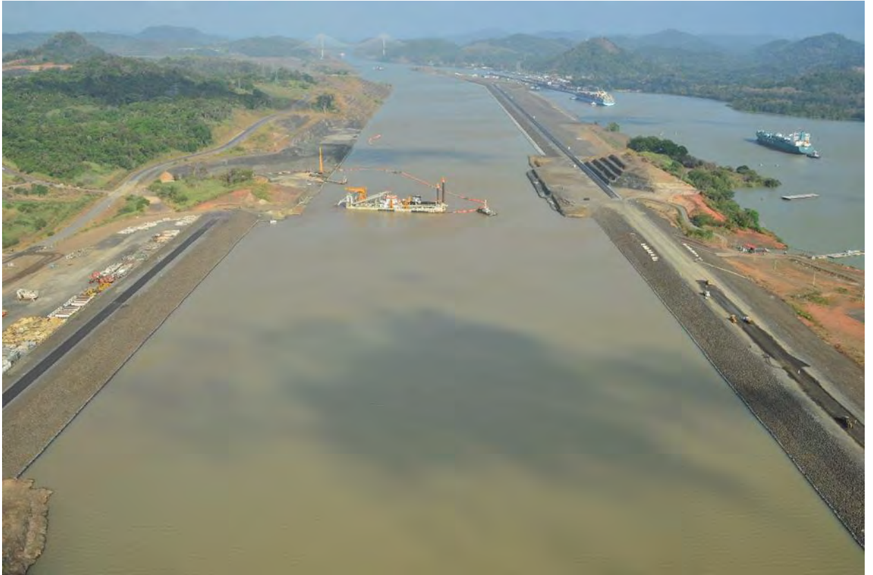
Figura No. 2. Vista aérea de la presa en dirección norte
