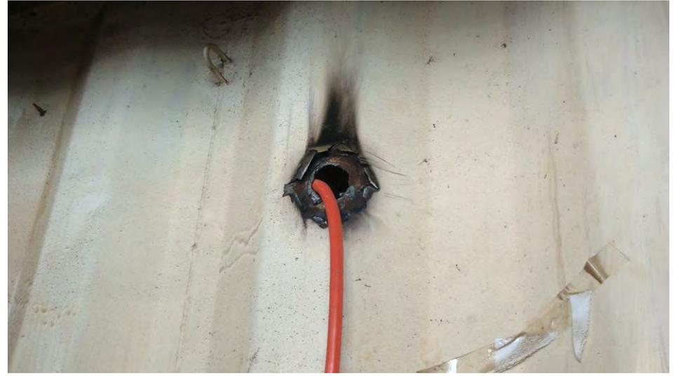
18. Situación insegura pasando cable eléctrico a través de agujerón con bordes cortantes - Esclusas Atlántico/ Unsafe condition passing electric cable through hole with sharp edges - Atlantic Locks
