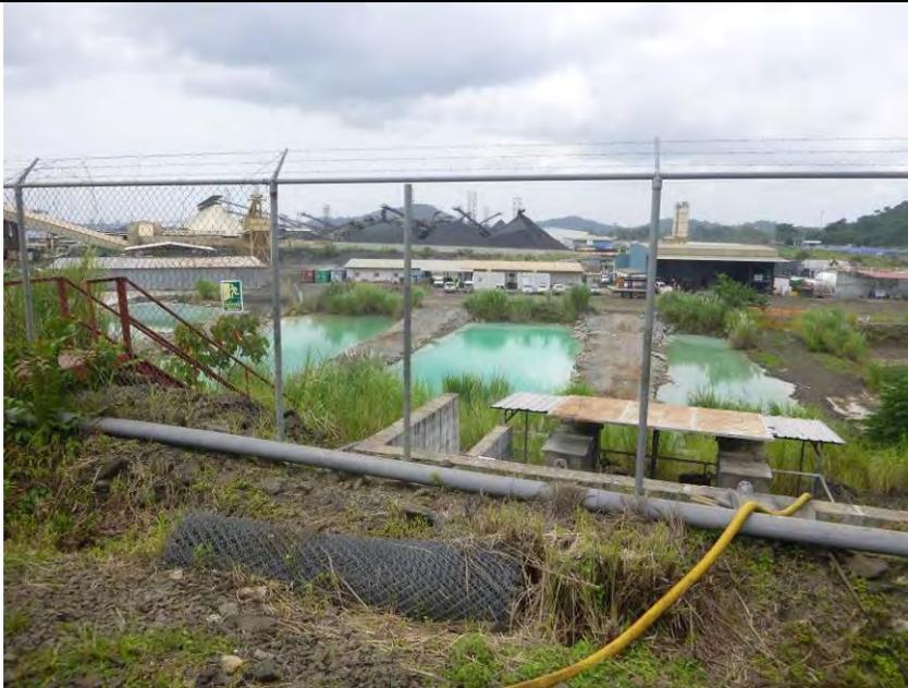
7. Mejoras en las tinas de sedimentación de las Esclusas Pacífico para incrementar el tiempo de retención y facilidad para mantenimiento y limpieza/ Improvements made to sedimentation ponds at the Pacific Locks site to increase retention time and facilitate pond maintenance/cleaning
