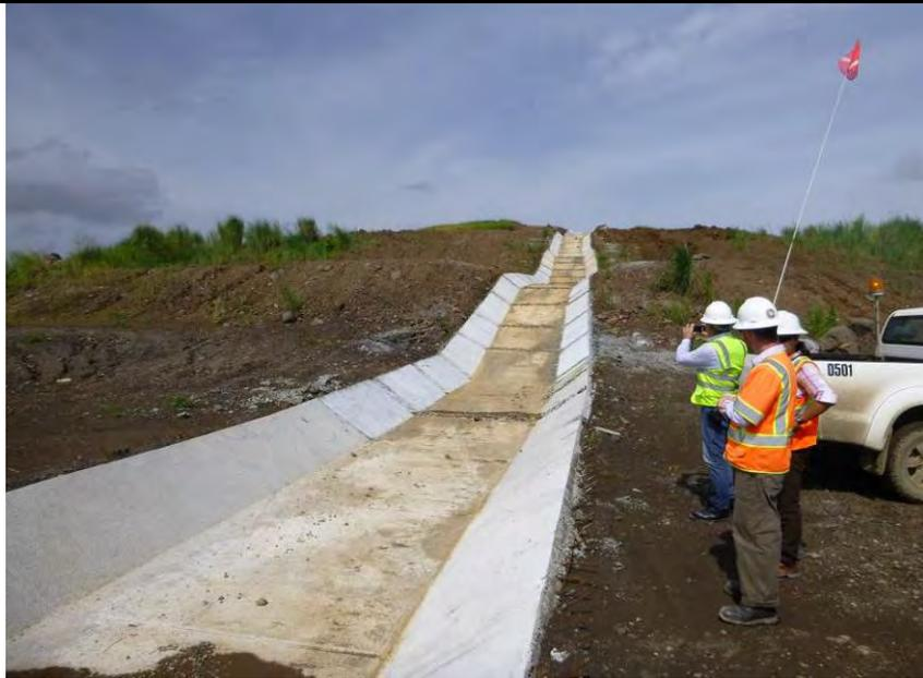
27. Medida de manejo de agua de escorrentía y protección de talud como medida de cierre en sitio de disposición - Esclusas Pacífico/Runoff management and slope protection measure as a closure measure at the disposal site - Pacific Locks.
