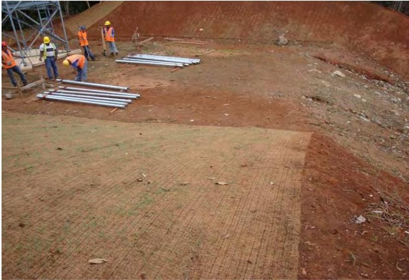
21. Uso de mantas de coco para control de erosión en torre de enfilamiento - Bohio, Lago Gatún / Coconut mates used for erosion control at navigation tower - Bohio, Gatun Lake
