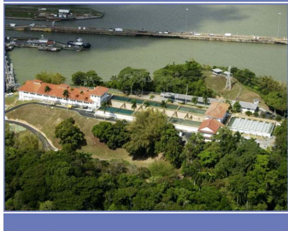
Figura A-41 La planta potabilizadora de Miraflores supe de agua potable a la areas revertidas, los barrios de San Felipe, Bella Vista y el Cangrejo además de las instalaciones de la ACP en el sector Pacífico.
