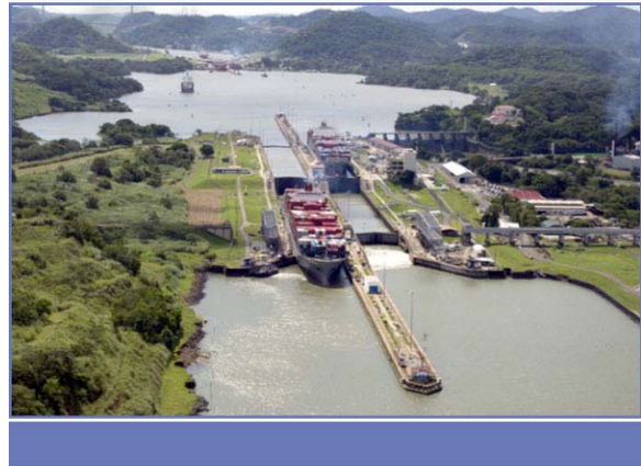
Figura A-8 Las Esclusas de Miraflores consisten de dos niveles.
