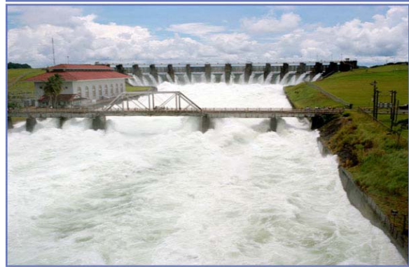
Figura A-31 El vertedero de la represa de Gatún sirve de control de inundaciones para evitar daños a las infraestructuras adyacentes al lago Gatún durante la estación lluviosa. Parte del agua vertida se usa para generar energía eléctrica.
