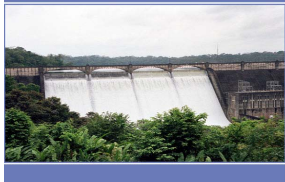
Figura A-33 El vertedero de la represa Madden se usa para controlar el nivel del lago Alhajuela. Parte del agua vertida se usa para generar energía eléctrica.
