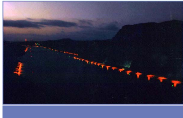
Figura A–26 La dificultad para la navegación por el Corte hace que su iluminación y señalización sean las más críticas de todos los canales de navegación del Canal.
