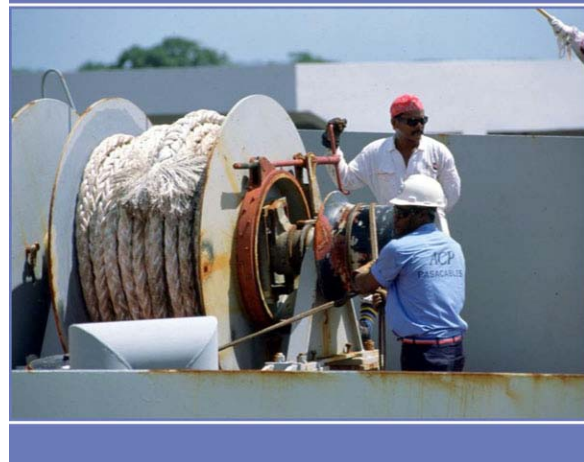
Figura A–22 El Canal cuenta con un total de aproximadamente 1,140 pasacables principalmente para asegurar los buques a los remolcadores y locomotoras.
