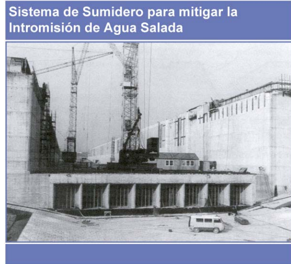
Figura 7-52 Sistema de mitigación de agua salada por medio de sumidero ( sump ) durante su construcción en las esclusas de Terneuzen, Países Bajos (Holanda), ha operado por más de 14 años.
