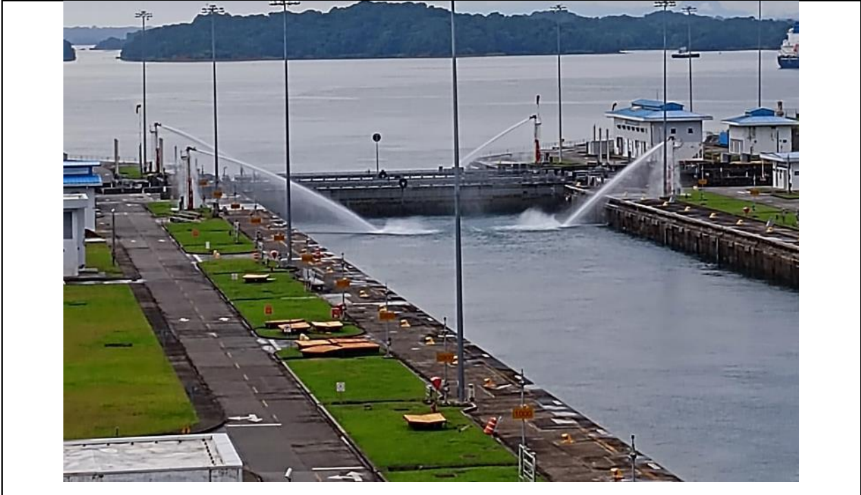
Foto3: Prueba a sistema contra incendio
