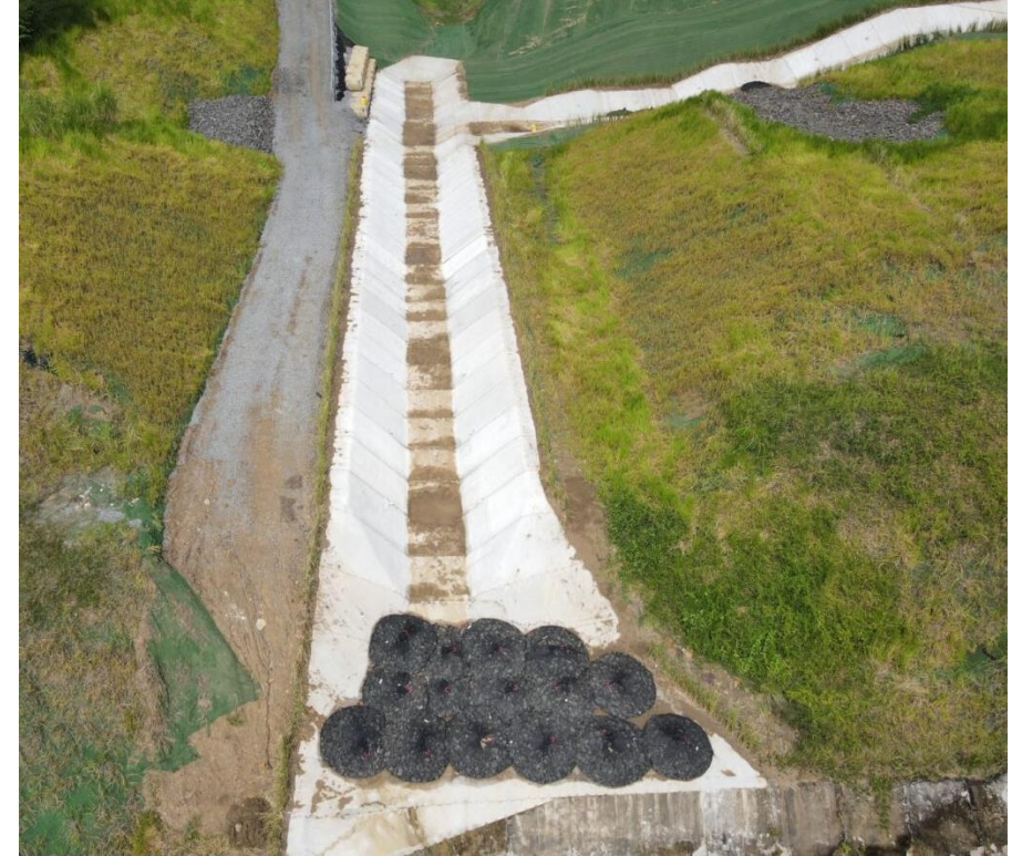
Rehabilitación del drenaje de Hagan, finalizado marzo 2023
