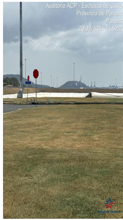
Se observó señalización incompleta (Cocolí)
