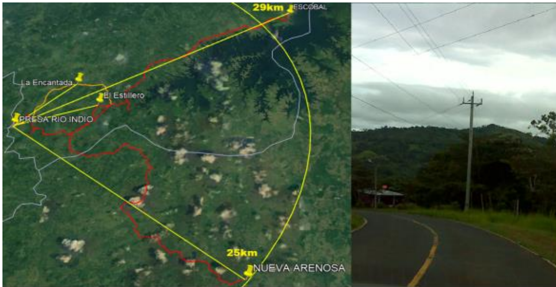
Figura 5. Línea trifásica de media tensión en Nueva Arenosa
