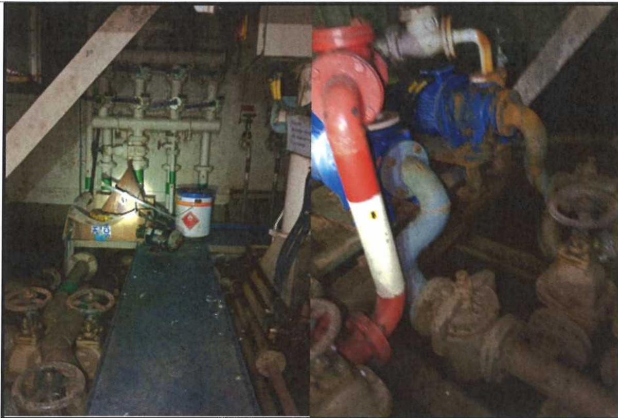
**Foto 44 & 45. Tuberías, Bombas, Válvulas y Piano de Válvulas en el Cuarto de Máquinas**
