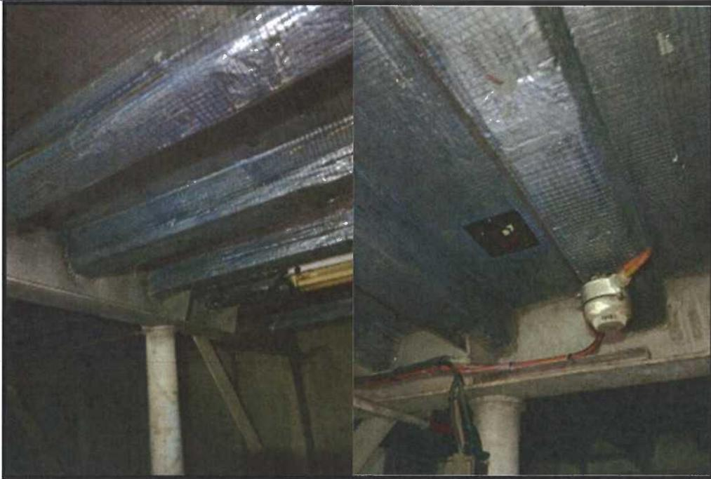
**Foto 37 & 38. Aislante Debajo de la Cubierta Principal**
