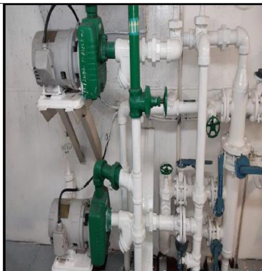
Figura N°20. Bombas de lastre/sentina y de enfriamiento de la propulsión (ok).
