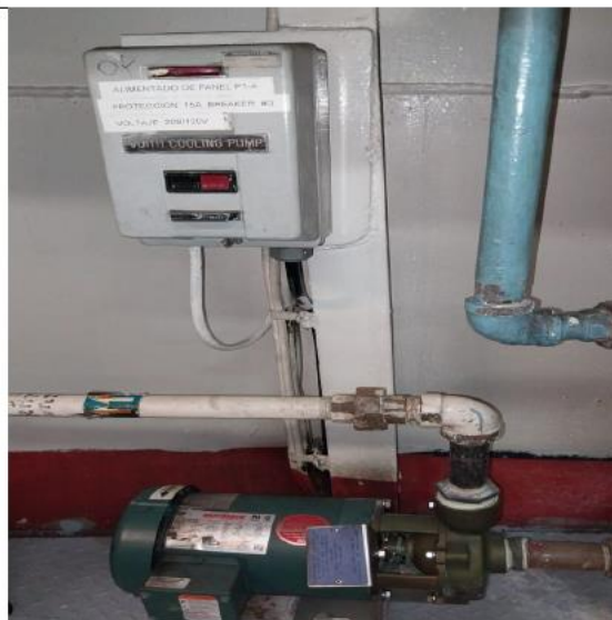
Figura N°20. Bombas de lastre/sentina y de enfriamiento de la propulsión (ok).
