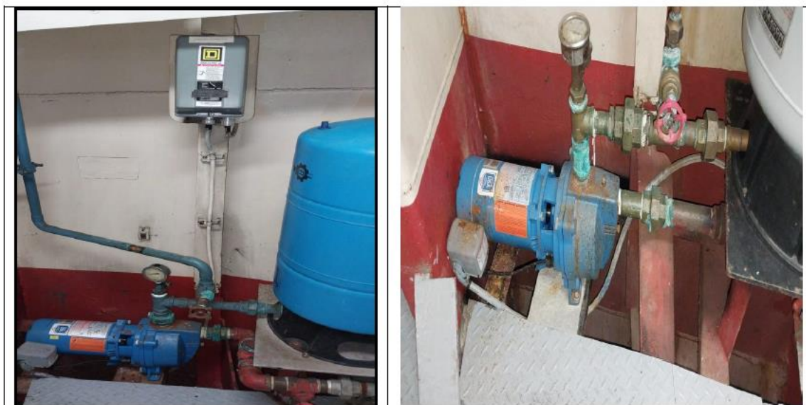
Figura N°21. Bombas de sistema sanitario y de Agua potable (ok).
