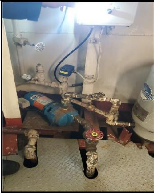
Figura N°21. Bombas de Sistema sanitario y de Agua Potable (ok).
