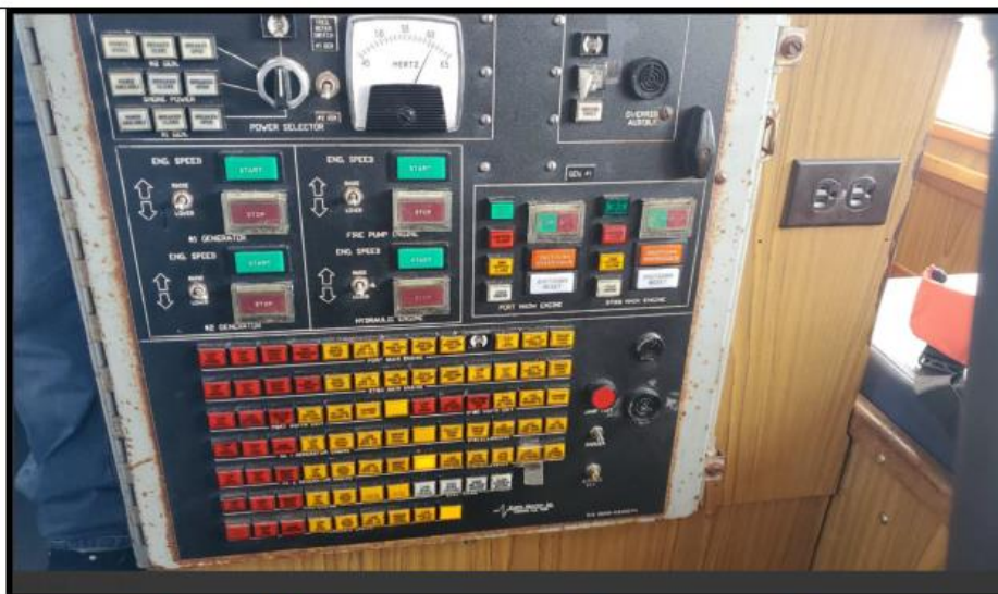
Figura N°30. Panel de alarmas del puente. (Operativo).
