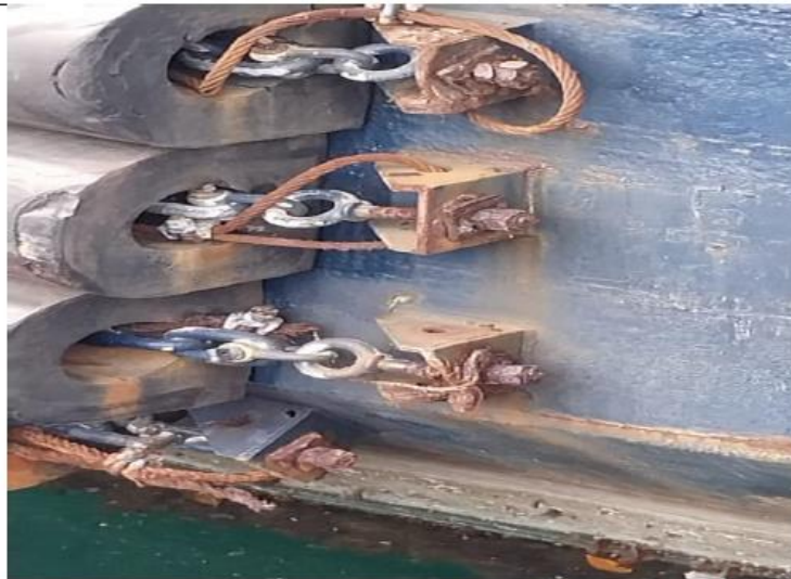
Figura N°36. Cadenas, láminas y elementos de sujeción de los defensas afectados por corrosión, en proa y popa de los lados de babor y estribor presentan esta condición.
