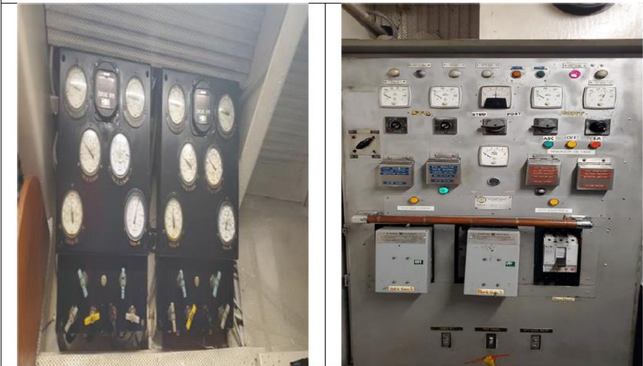
Figura N°34. Sistema de monitoreo de máquinas principales / “Switch board” de generadores (Operativo).
