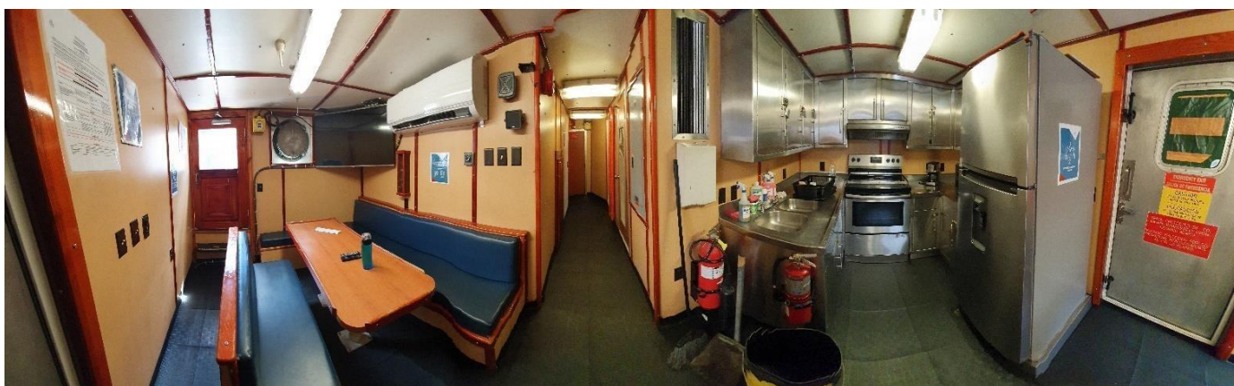
Figura N°31. Condición de acomodaciones de la cubierta. (Buena).
