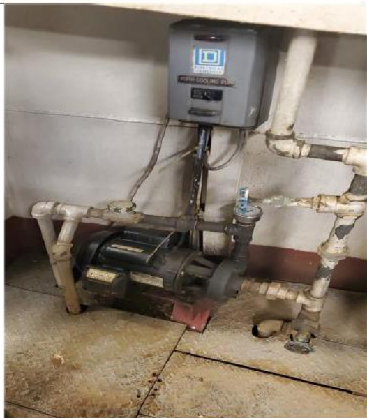
Figura N°20. Bombas de enfriamiento de la propulsión (babor/estribor) (ok).
