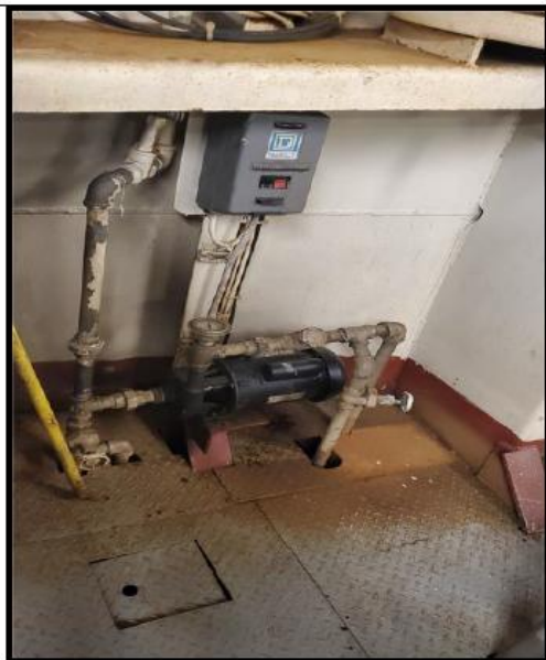
Figura N°20. Bombas de enfriamiento de la propulsión (babor/estribor) (ok).
