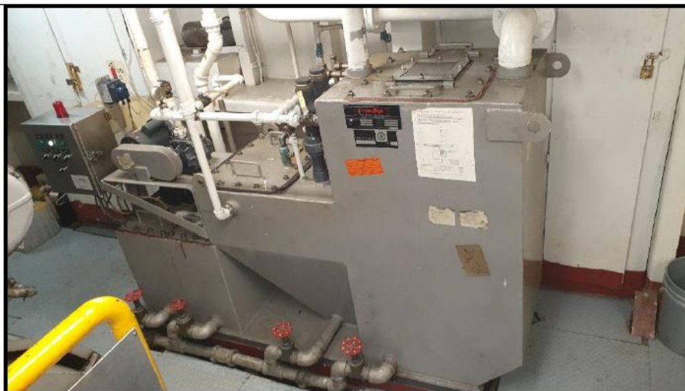
Figura N°16. Planta de tratamiento. (Operativo)
