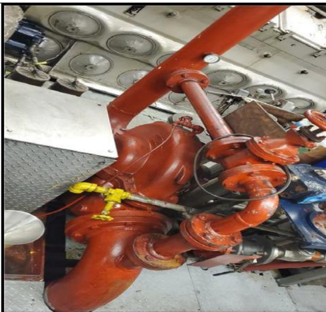
Figura N°14. Bomba FIFI (Operativo).
