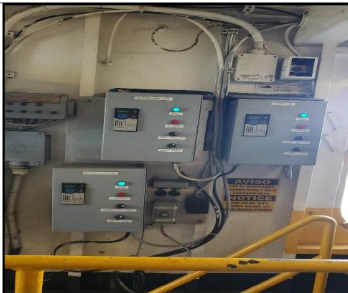
Figura N°15. Ventiladores, Extractor y sus paneles de control (Operativo).
