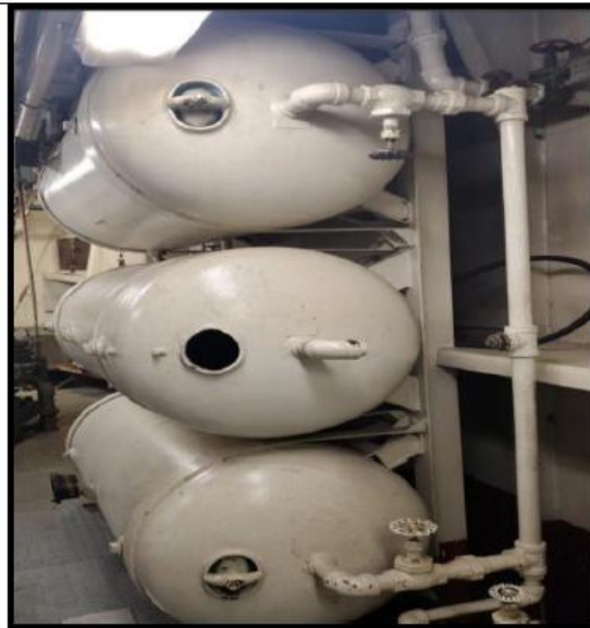
Figura N°12. Tanques de Aire N°1 y N°3 (Operativo), Tanque N°2 (No Operativo).
