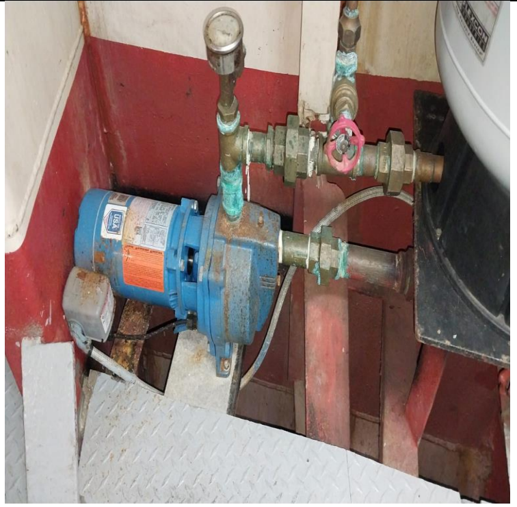
Figura N°21. Bombas de sistema sanitario y de Agua potable (ok).
