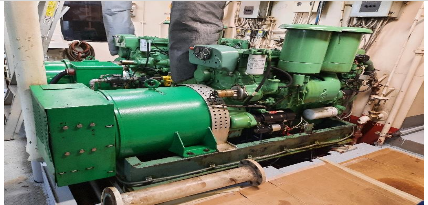
Figura N°9. Generador N°2 (Operativo).
