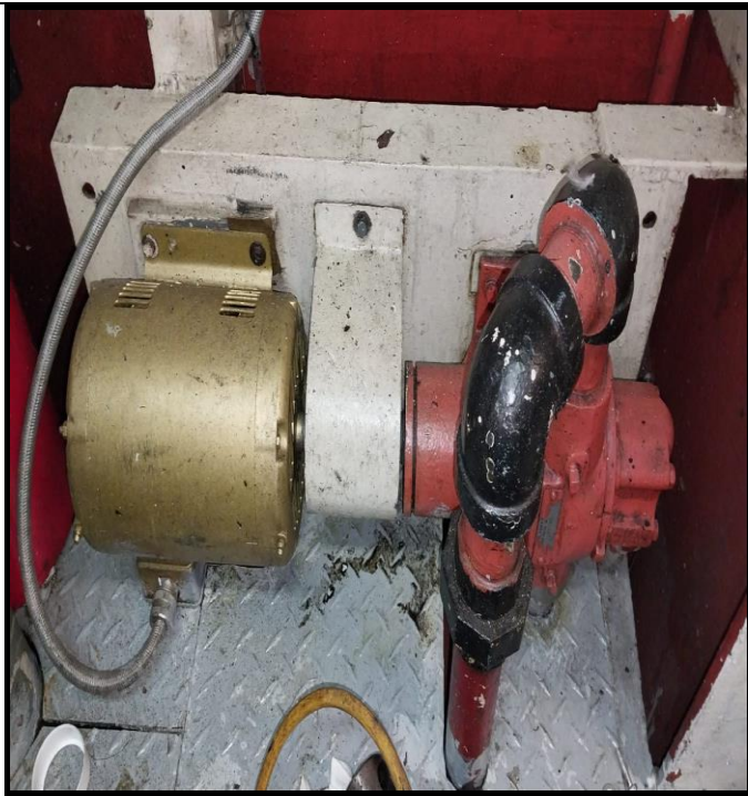
Figura N°22. Bombas de prepublicación de máquinas principales (babor/estribor) (ok).
