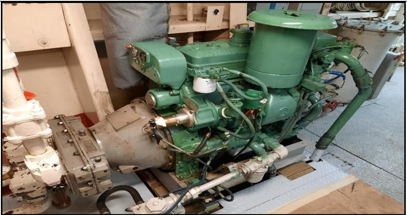
Figura N°10. Máquina hidráulica (Operativo).
